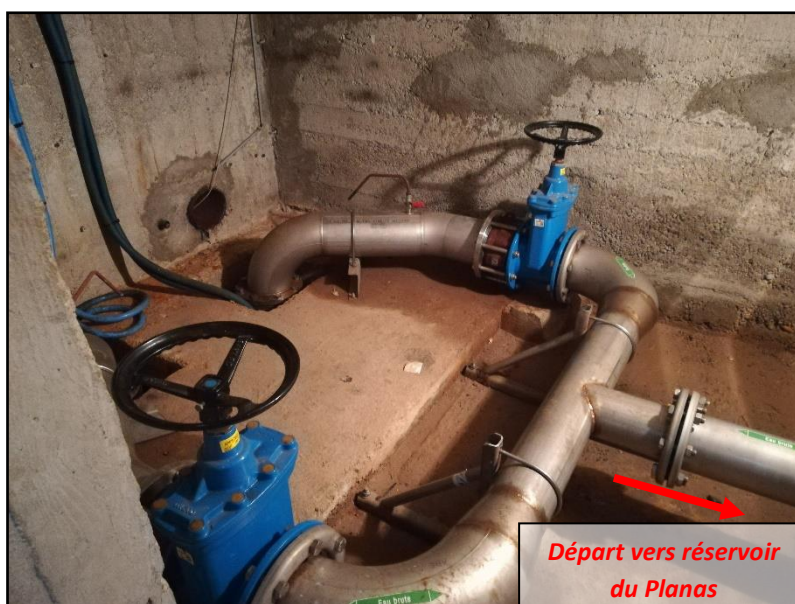
Figure 5 : Photographie de l'exhaure des 2 pompes
